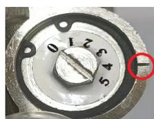
Установочная риска настройки клапана регулировки потока (байпас).
