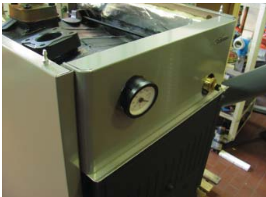
Рис. 29 Снять термометр
