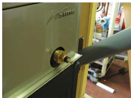
Рис. 28 Предохранительный термостат
